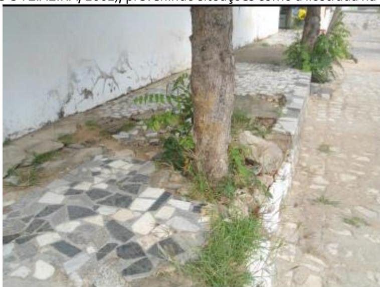
Figura 05: Levantamento e quebra de calçada por falta de espaço livre na pavimentação. Fonte: Josival, março/2014
