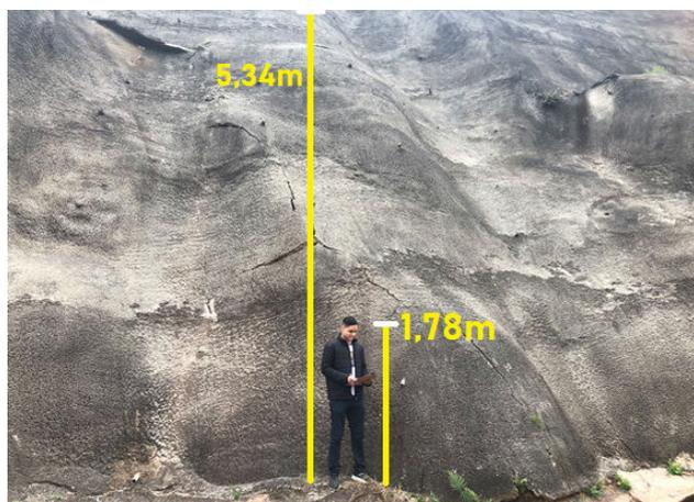
Figura 12. Contenção de encosta apresentando fissura. Obra localizada via de acesso João Roman. Captura realizada pelos autores em vista de campo, 2019.
